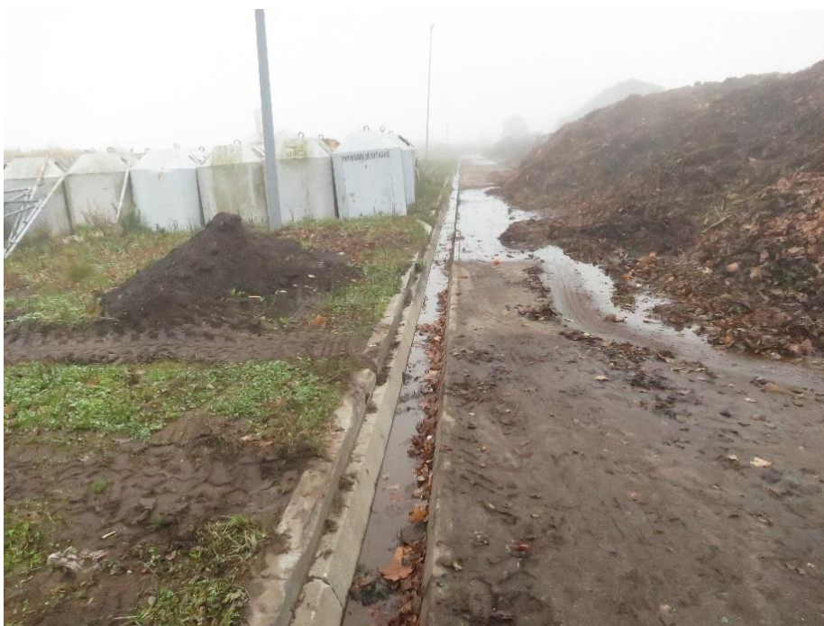
5.3 pav. Įvažiavimas į žaliųjų atliekų kompostavimo aikštelę. Kompostavimo filtratas latakais patenka į kaupimo filtrato sistemą
